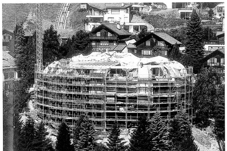
Baustelle Chesa Futura von Lord Norman Foster und Küchel Architects 2003
